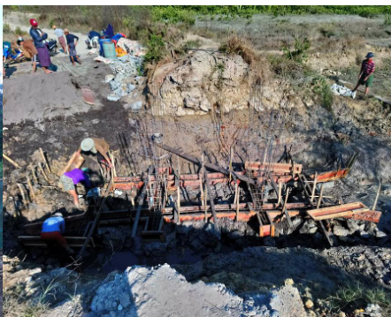
ရေထိန်းတံခါး တည်ဆောက်ခြင်း
